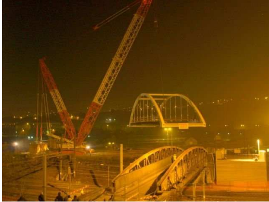
Placement du pont à l'aide d'une grue.
