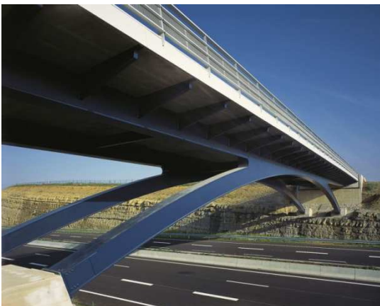
Pont terminé et construit.
