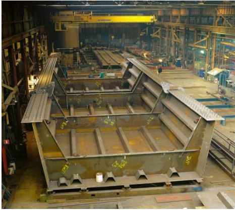
Assemblage en ateliers.
